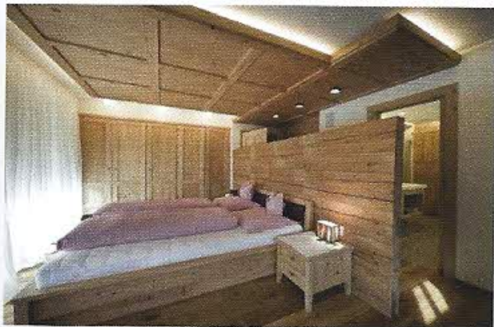
Auch die LED-Technik hielt Einzug: Hinter den Holzverkleidungen wurden LED-Leuchten verbaut und sorgen für angenehmes Licht.
